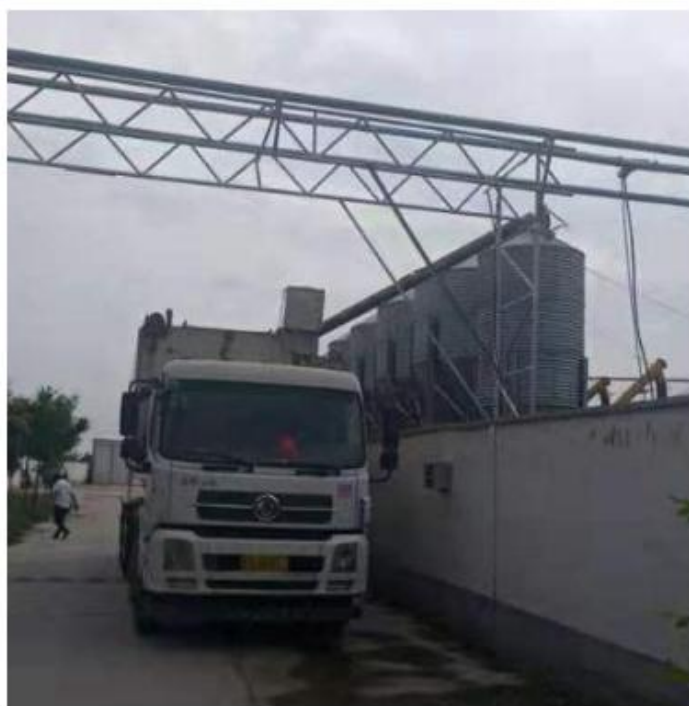
图2.3-9 饲料运输、上料示例图（料车至料罐）
