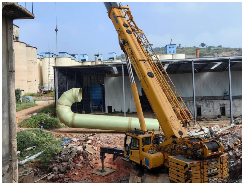
附图 11 项目厂区现场拆除照片图
