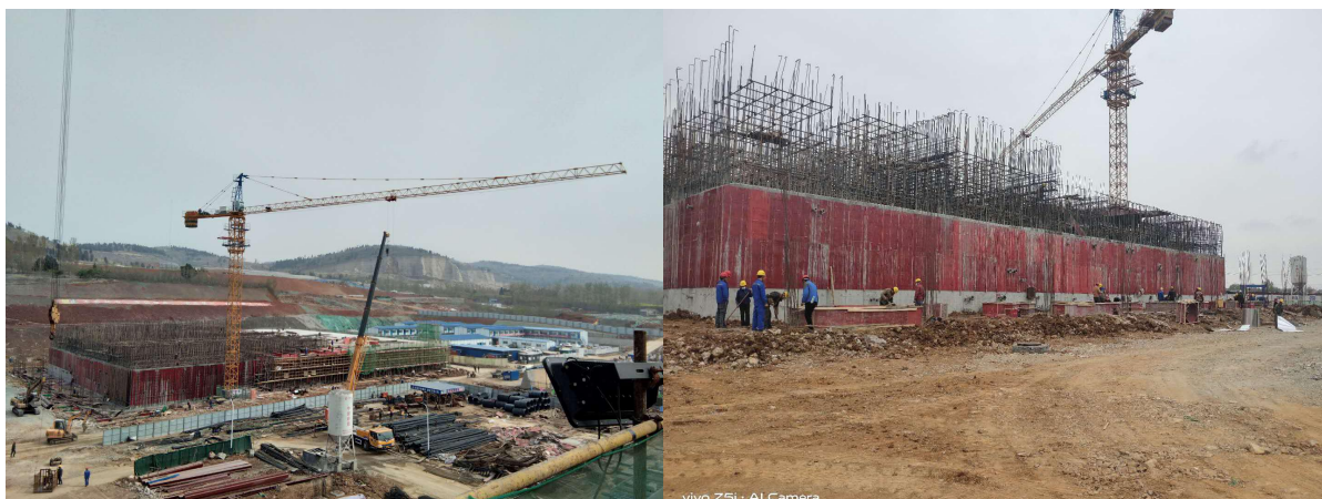
新建的 600m 3 /d 渗滤液处理站现状建设情况：土建基本完成
