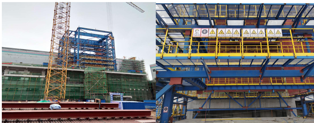
1#锅炉组装施工
