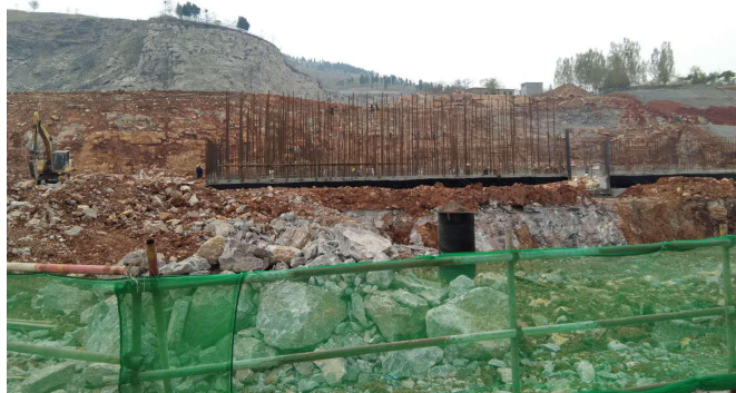
综合水泵房施工
